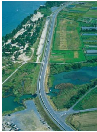
(a) 湖岸堤の建設
