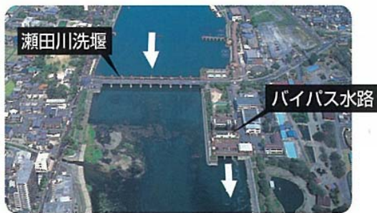
(f) 瀬田川洗堰の改築
