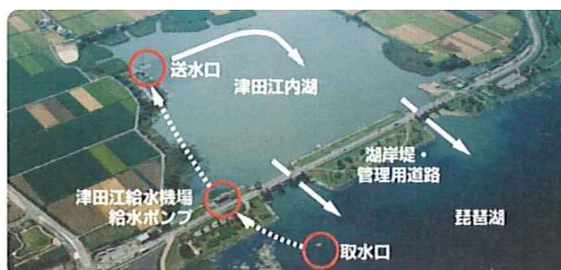
写真 1.3-2 津田江内湖の水位保持施設
