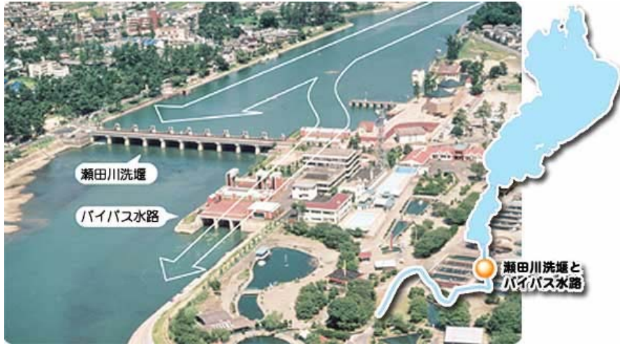
図 1.3-7 瀬田川洗堰バイパス水路
