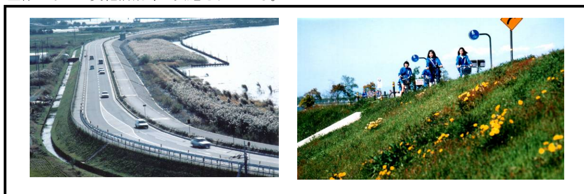
図 7.5-16 湖岸堤・管理用道路の利用状況
