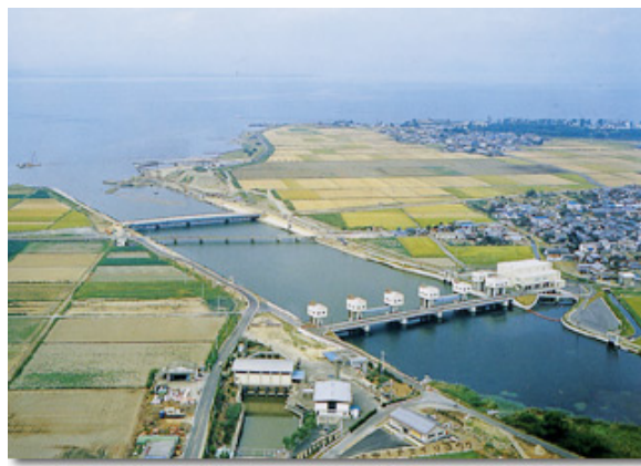
(b) 内水排除施設
