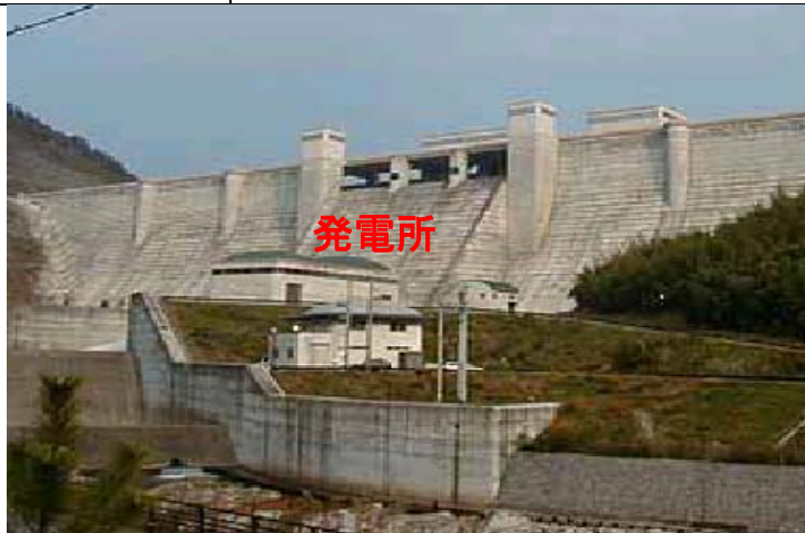
写真 3.2.6-1 比奈知発電所
