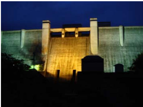
図 7.3.2-3(2) ダムの堤体ライトアップ
