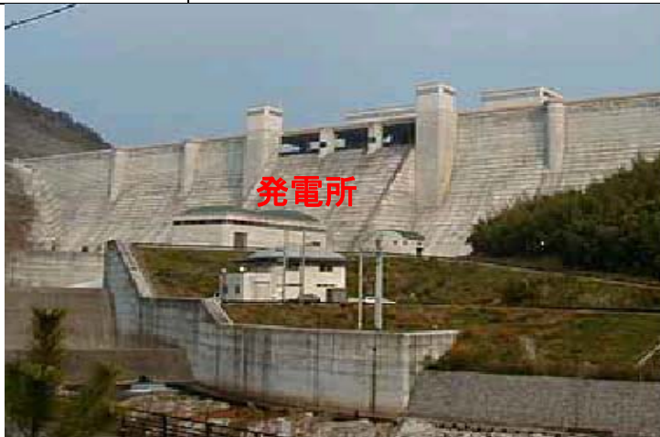
写真 3.2.6-1 比奈知発電所
