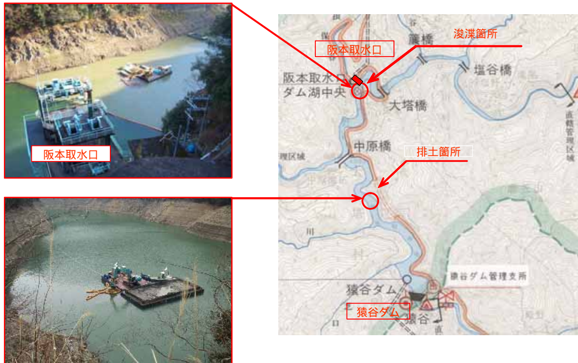
図 5.6-3 阪本取水口付近の浚渫の様子
