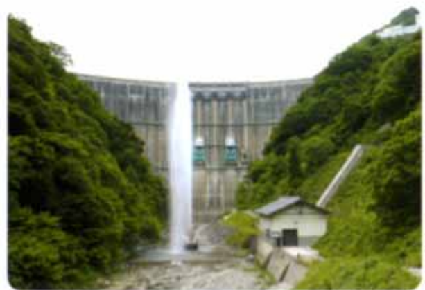
写真 3.3 - 2 噴水によるダム直下放流の様子
