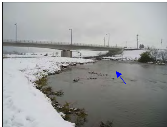
富田大橋左岸側の寄り洲（川幅が狭くなる場所） ゴミが陸上に残っている形跡は確認されなかった（平成 17 年 12 月 10 日）。
