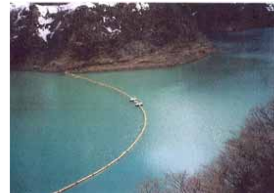
濁水防止フェンス設置状況
