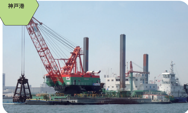
物流効率化や交通課題の緩和を目的に、道路事業者とともに大阪湾岸道路西伸部の整備を進めており、港湾では橋脚設置に伴う航路切替を実施しています。
