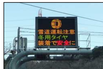
道路情報表示板 各種道路情報や注意喚起をドライバーに提供しています。マルチカラー表示や分かりやすい文字図形による表示を実施しています。
