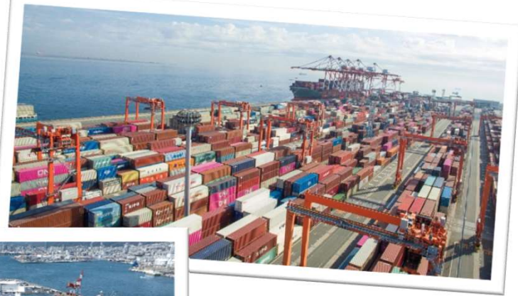
神戸港コンテナターミナル
