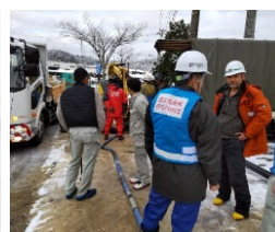
修繕工事箇所の確認状況 (穴水町)
