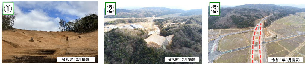
周枳地区 森本地区 森本地区(第一高架橋)
