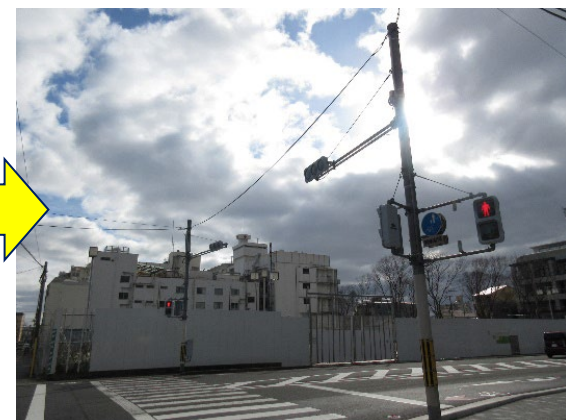
地上部除却後
