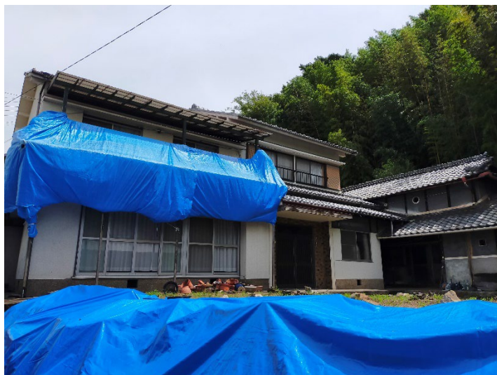
危険住宅除却前
