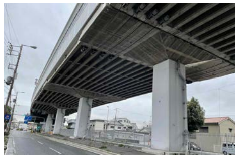
堺市 堺高架橋(全景)
