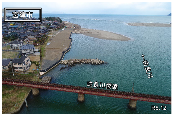
由良・石浦地区 堤防整備状況②
