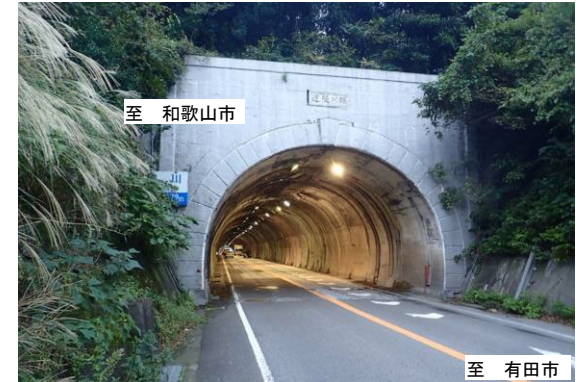
鯨川トンネル(全景)
