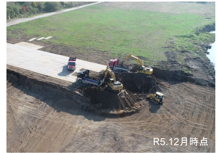
横大路地区 河道掘削状況
