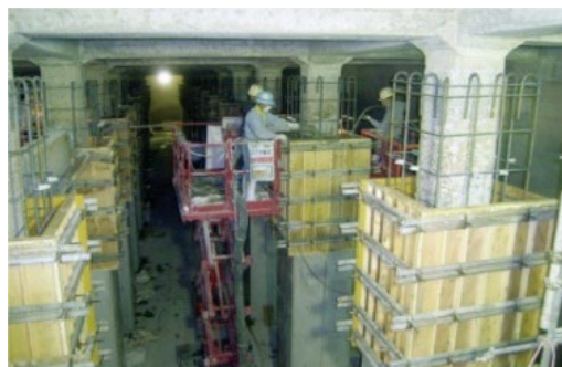
配水池の耐震化工事(内面からの壁・柱等の補強)
