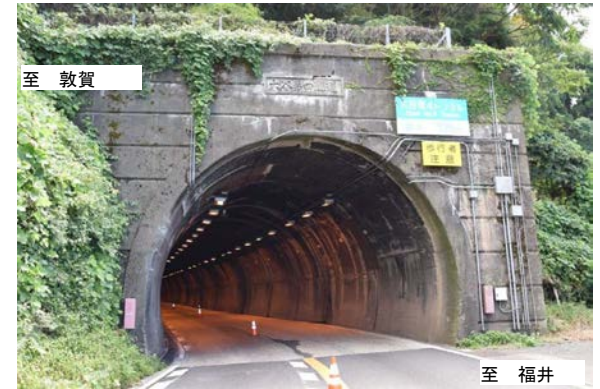
大谷第4トンネル(全景)
