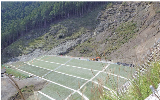
冷水地区 押え盛土工 【令和2年9月一部完成】
