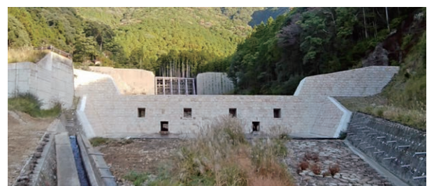
那智川流域 樋口川1号堰堤（本堤） 【平成26年3月完成】
