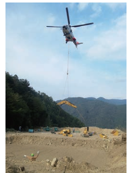
ヘリコプターによる分解型重機の運搬
