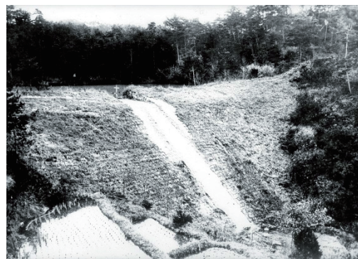
不動谷堰堤 （京都府相楽郡棚倉村綺田不動川） 施工指導者：ヨハネス・デ・レーケ
