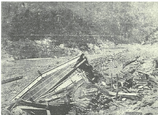
北十津川村大字長殿 流失・倒壊家屋 （写真：吉野郡水災誌復刻版より）
