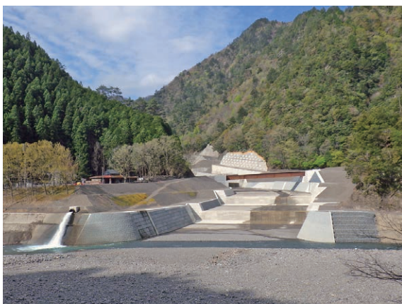
赤谷地区 溪流保全工【令和元年 11 月完成】
