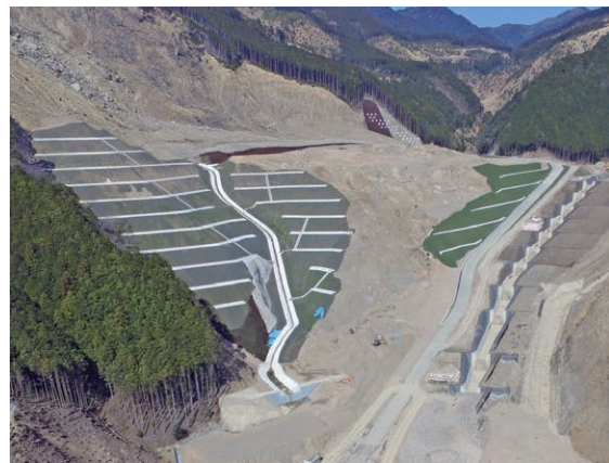
熊野地区 表面排水路工【平成 29 年 1 月完成】
