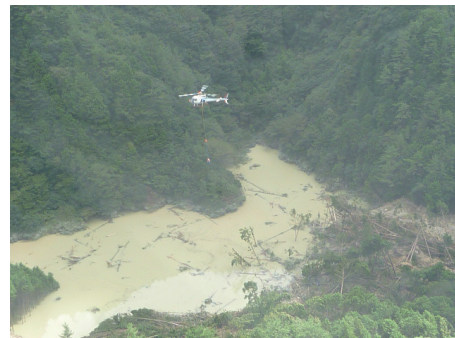
ヘリコプターから湛水池へ投下 (熊野地区)
