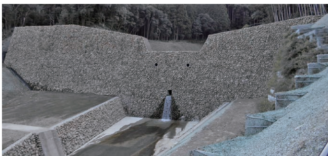
那智川流域 鳴子谷川1号堰堤（本堤） 【令和元年12月完成】
