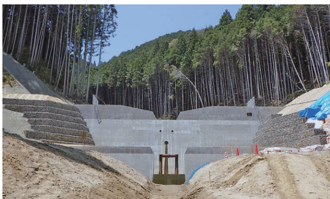
谷出第3堰堤（本堤） 【令和2年3月完成】
