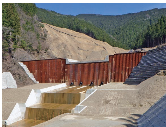
北股地区 2号砂防堰堤【平成 29 年 1 月完成】
