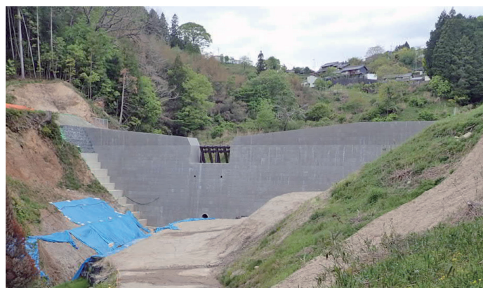
室生口堰堤（本堤） 【令和2年3月完成】
