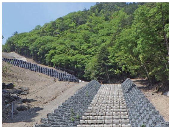
長殿地区 仮排水路工【平成 28 年 3 月完成】
