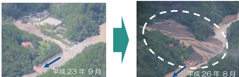
平成 23 年 9 月 平成 26 年 8 月 荒廃地からの土砂流出に伴う河床上昇による治水安全度の低下 (赤谷川 川原樋川合流地点 (五條市))
