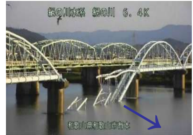
六十谷水管橋落橋状況 (和歌山県国道事務所CCTV)
