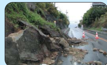
法面崩落状況 (串本町和深地先)
