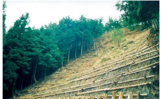
御杖村 平成2年度施工地
