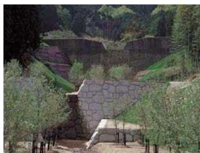
坂ノ下堰堤（100基目） 【平成13年3月完成】
