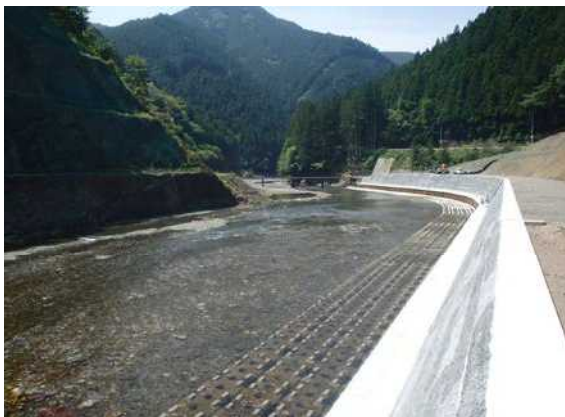
坪内地区 護岸工+護床工 【平成 29 年 7 月完成】
