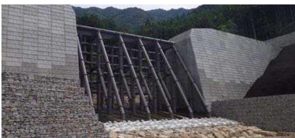
那智川地区 樋口川 2 号堰堤 【平成 28 年 3 月完成】
