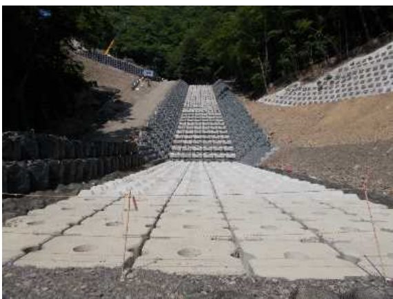
長殿地区 仮排水路工【平成 28 年 3 月完成】
