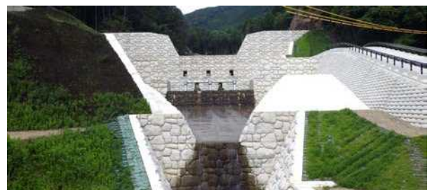
那智川地区 金山谷川 2 号堰堤 【平成 29 年 3 月完成】
