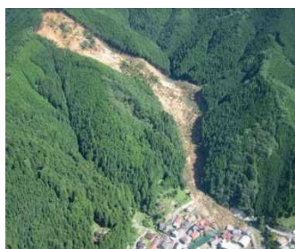
河道閉塞発生直後 (野迫川村北股地区)
