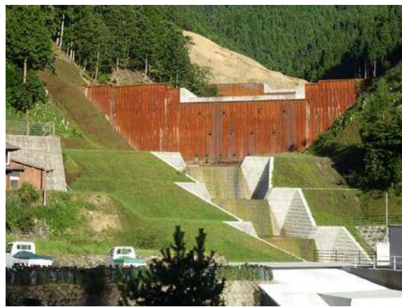
北股地区 溪流保全工【平成 28 年 12 月完成】
