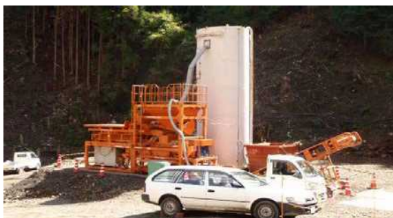
砂防ソイルセメントの製造の自動化 (長殿地区)
