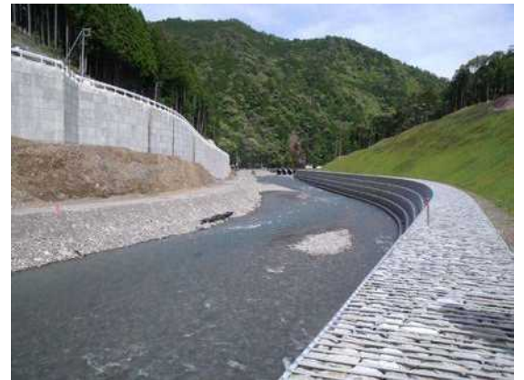
三越地区 護岸工 【平成 28 年 12 月完成】
