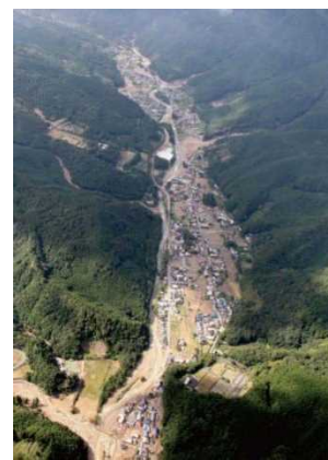
土石流発生直後 (那智勝浦町那智川地区)
