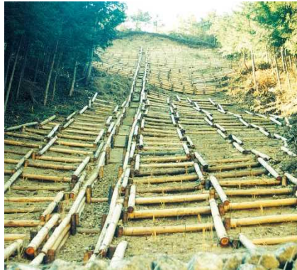
御杖村 平成元年度施工地
