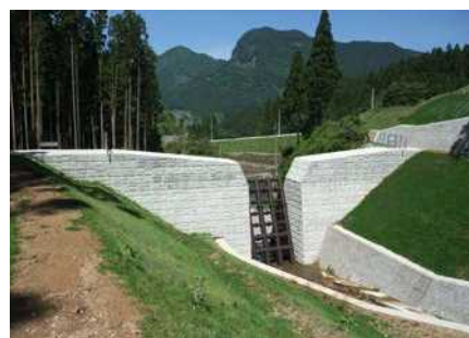
太良路川堰堤 【平成27年3月完成】
