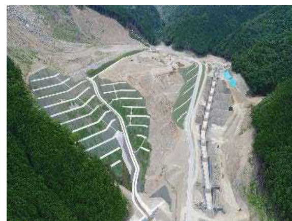
熊野地区 表面排水路工【平成 29 年 1 月完成】
