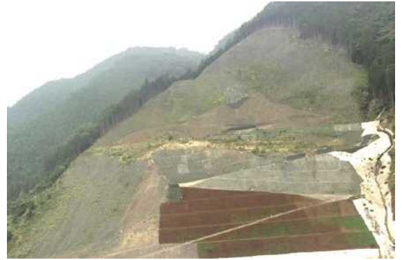
清水（宇井）地区 排土工+斜面抑止工 【平成 28 年 8 月完成】
