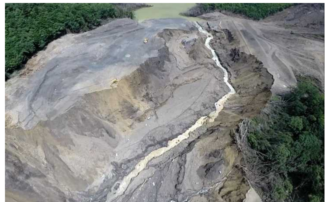
越流侵食：平成26年台風11号（栗平地区）
