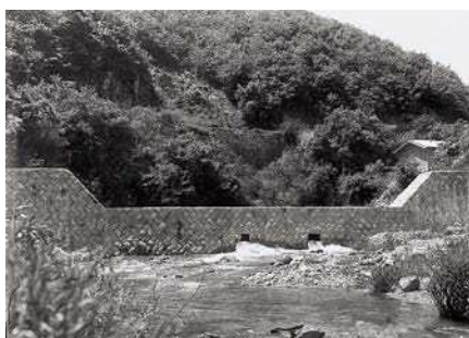
葛尾堰堤（1基目） 【昭和27年3月完成】
