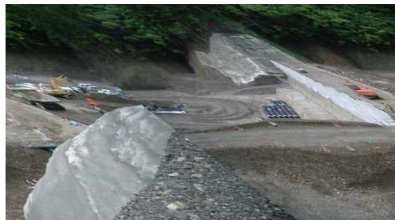
砂防ソイルセメントによる 砂防堰堤の施工状況 (赤谷地区)
