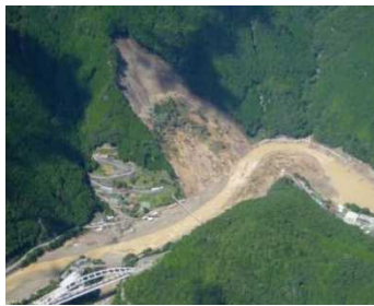
深層崩壊発生直後 (五條市清水(宇井)地区)
