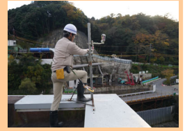
カメラ設置状況
