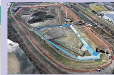
遊水地整備 (大和川)
