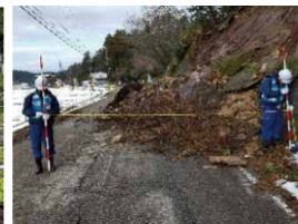
被災状況調査 【能登半島地震】
