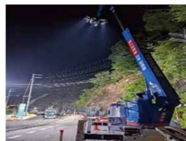
照明車による夜間復旧作業 【令和4年5月奈良県の斜面崩落】
