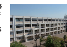
■校舎の耐震改修
