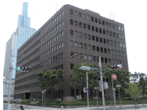
神戸地方合同庁舎（免震改修）
