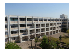
■校舎の耐震改修
