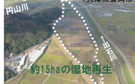
加陽地区の大規模湿地再生(兵庫県豊岡市)
