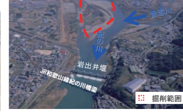
流下能力の不足箇所(紀の川)
