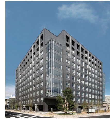
【建替による耐震性能の強化】 大津びわ湖合同庁舎
