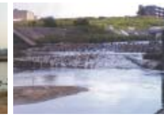
河川内の連続性確保（天野川落差工の改良）
