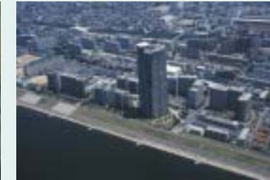
高規格堤防の整備により淀川沿いに住居が並ぶ西島地区
