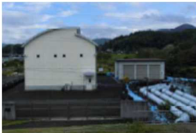
弘法川排水機場
