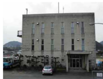
荒河排水機場
