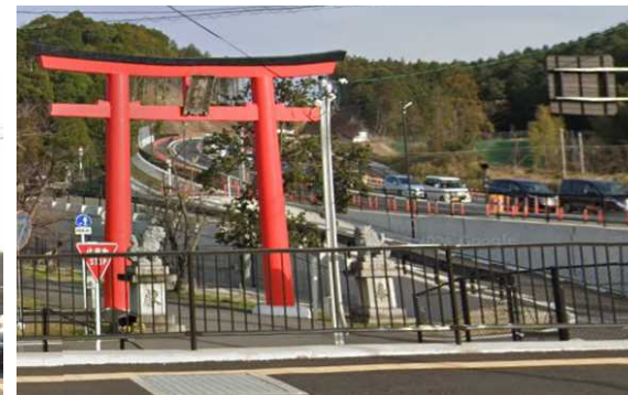
写真②周辺の景観に配慮した防護柵
