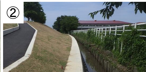
② 現況の法面と同等勾配で復旧し、植生により周辺景観と調和させ、ドレーン高を極力低くし、堤脚部の改変を軽減
