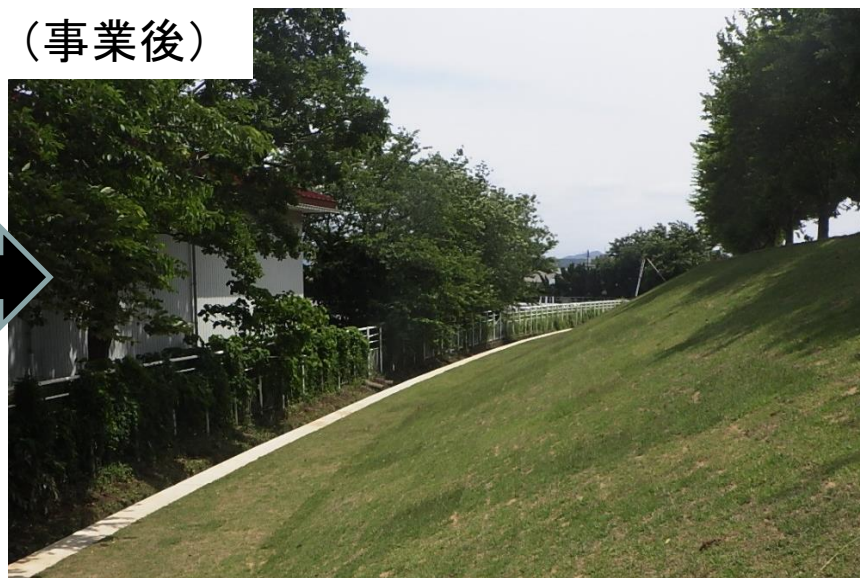
① 景観への影響を軽減させるため、法面をなだらかに摺付け、張芝工を実施
