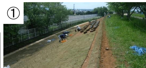
① 景観への影響を軽減させるため、法面をなだらかに摺付け、張芝工を実施
