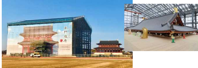
南門復原工事の様子
