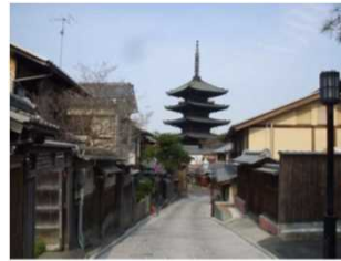
無電柱化事業：八坂通(完成写真)
