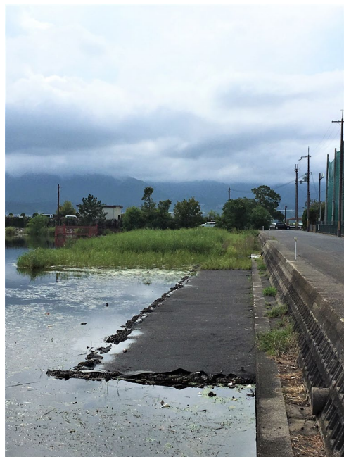
覆土工及び植生工の実施状況（木浜内湖）
