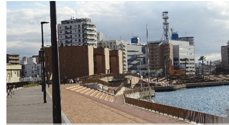
整備された親水護岸（堺旧港）
