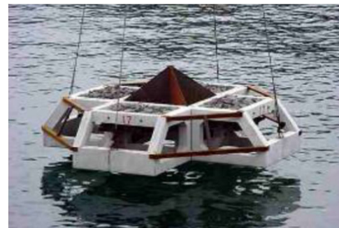
設置された攪拌ブロック礁 (岸和田市地先海域)
