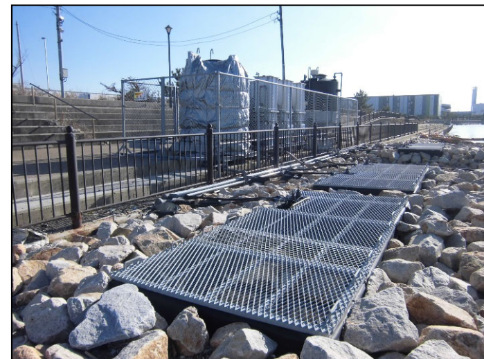
浄化材を用いたタイドプール (堺浜)
