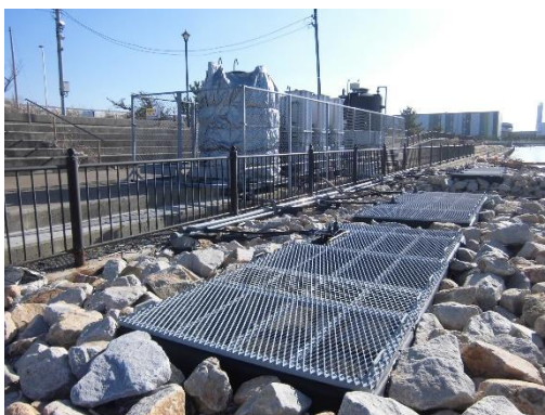
図 46 浄化材を用いたタイドプール
