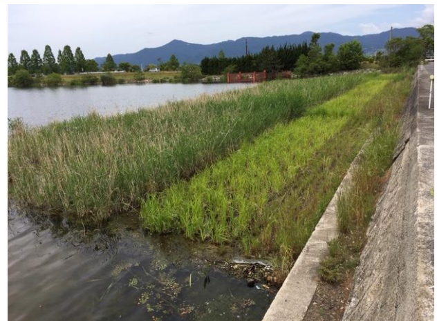
図 11 覆土工及び植生工の実施状況 (木浜内湖) 図 12 植生工の実施状況 (木浜内湖)
