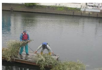
粗朶沈床設置
