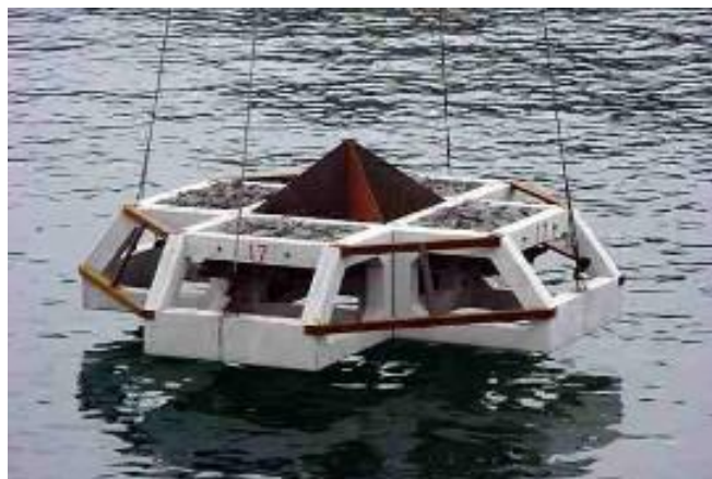
図 58 設置された攪拌ブロック礁（岸和田市地先）
