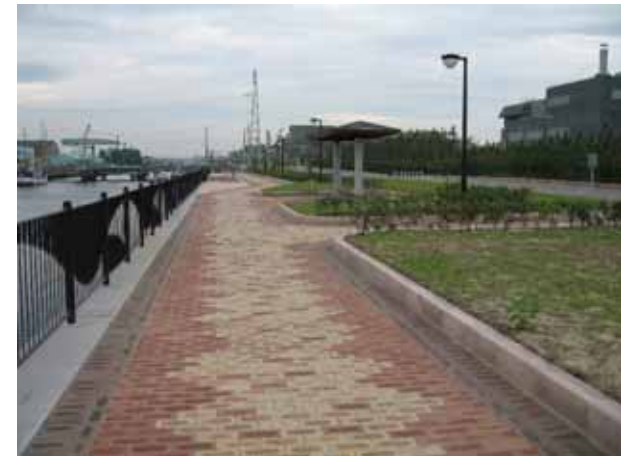
遊歩道整備、植栽等の整備 (尼崎運河部)
