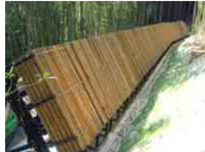
落石防止施設の緩衝材に 間伐材を利用
