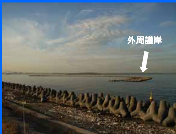
堺泉北港堺第2区人工干潟(造成中)
