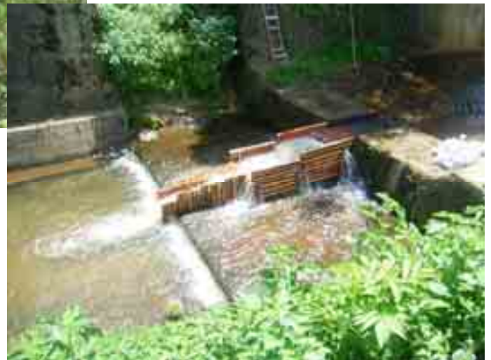
間伐材による魚道の設置風景
