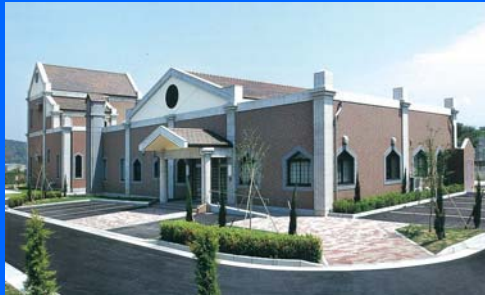
南あわじ市広田浄化センター 外観
