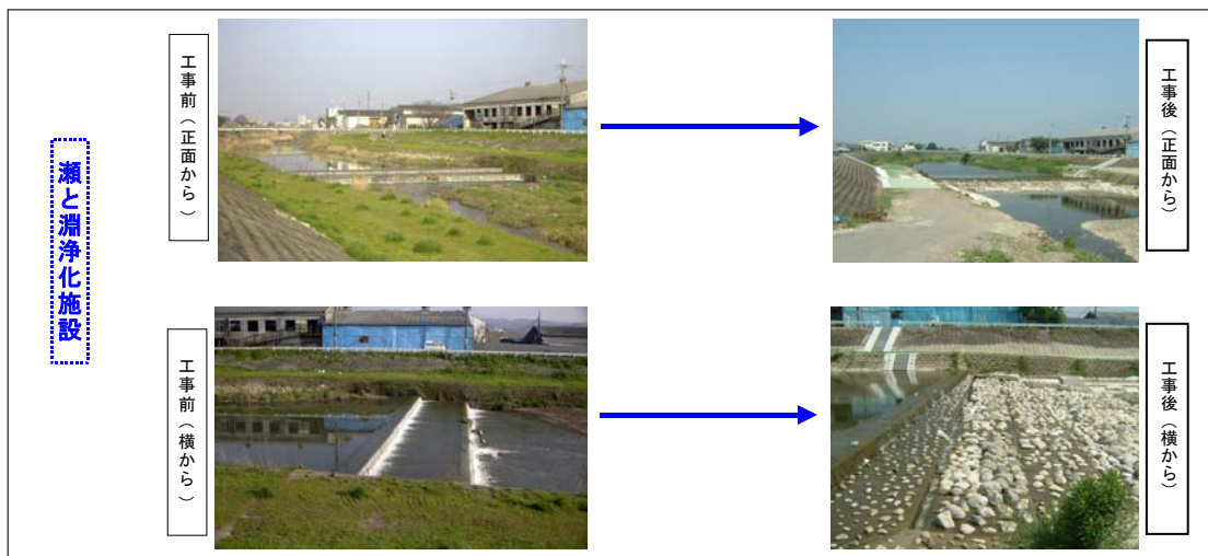
図 4-14 河川浄化施設設置状況（樫井川 瀬と淵浄化）
