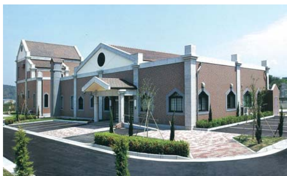
南あわじ市広田浄化センター 外観
