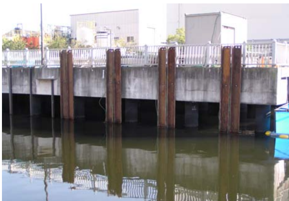
エコシステム護岸実証実験
