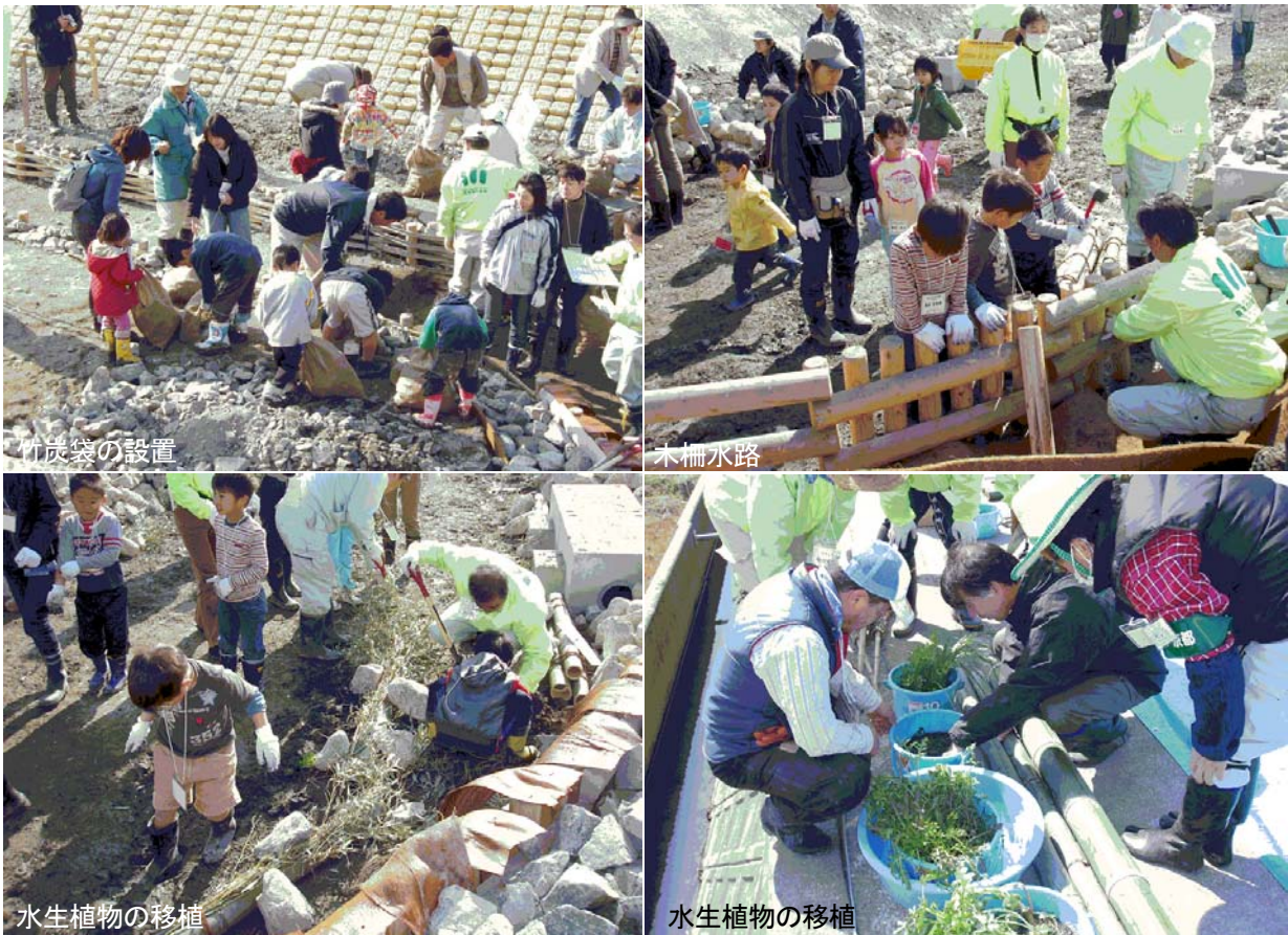
巨椋池干拓地幹線排水路工事（竹炭による水質浄化、水生植物植栽）
