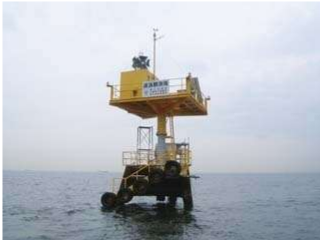
水質定点自動観測 (神戸港波浪観測塔)
