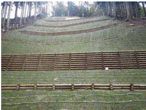
間伐材を利用した山腹工
