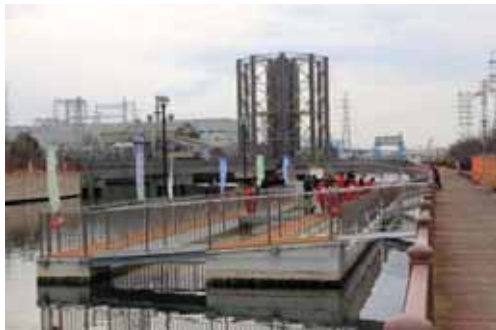
写真提供：兵庫県 整備完了した水質浄化機能付親水護岸
