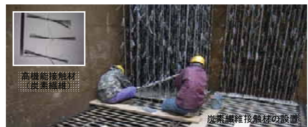
高効率接触材への入替え（曾我川浄化施設）
