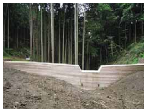
間伐材を用いた残存型枠による治山ダム 写真提供：京都府
