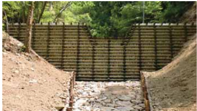
間伐材を利用した溪間工
