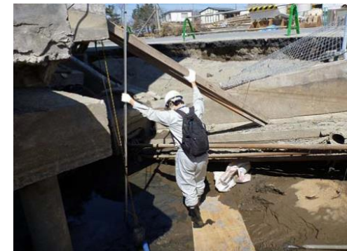
官庁施設の被災状況調査
