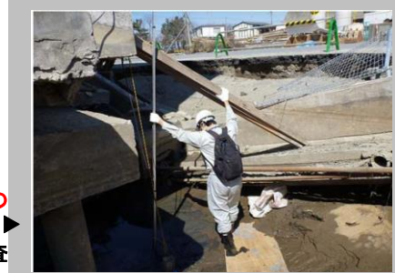
災害発生時の営繕部局の役割の例 官庁施設の被災状況調査 ▶
