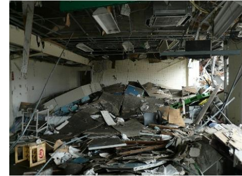
東日本大震災における津波による被害
