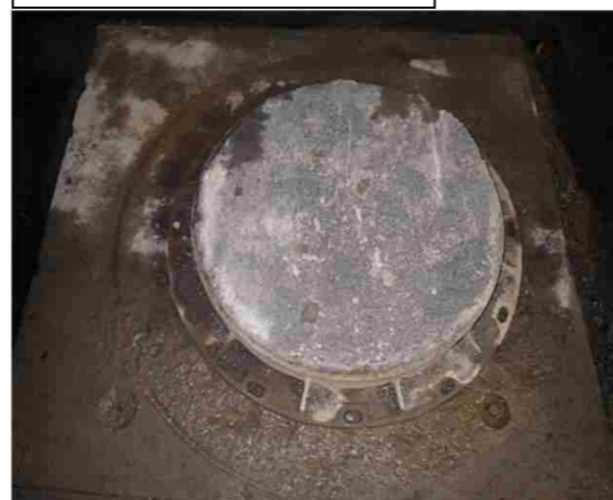
事故状況写真③ マンホール蓋嵩上げ作業
