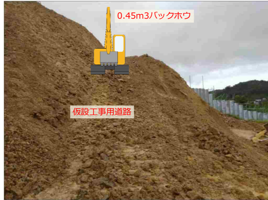
作業終了時0.45m 3 バックホウ停車位置
