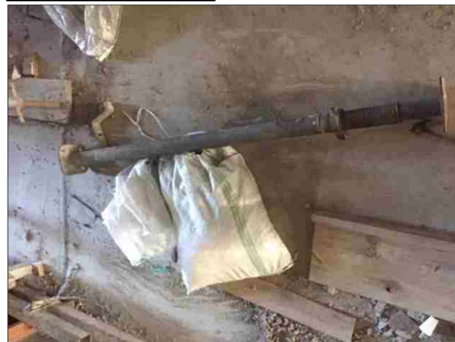
被災者に当たったパイプサポート
