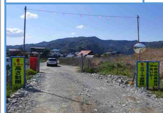
再発防止対策① 車両高さ制限設備の設置 ミラー・注意喚起の立看板設置
