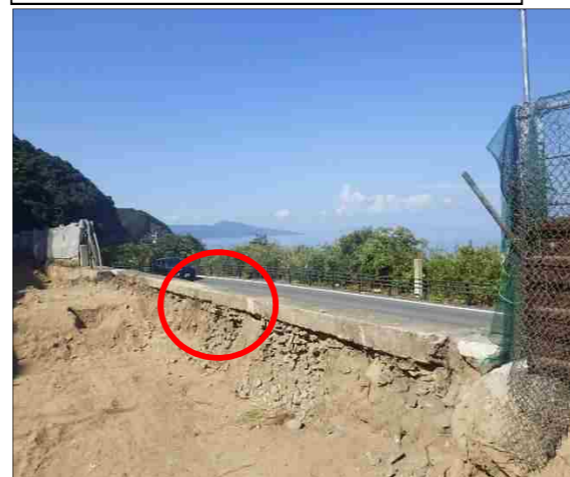
事故状況写真② バケット接触箇所
