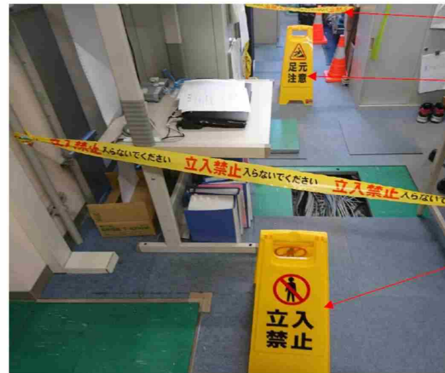
再発防止対策 作業区画の明示・安全標識の設置
