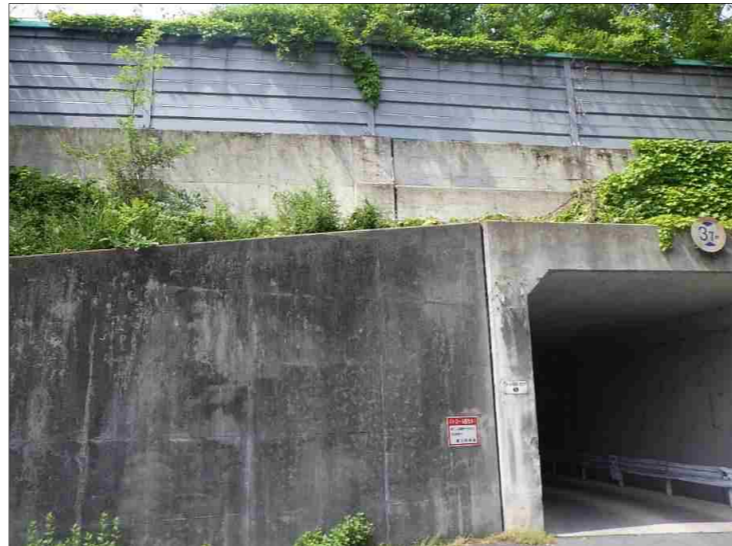
事故状況写真①
