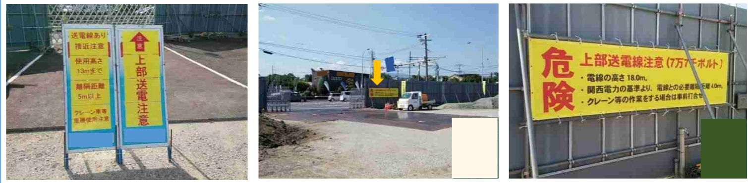
再発防止対策 注意喚起物の増設
