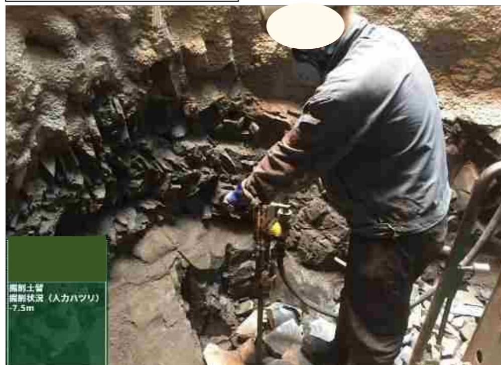
事故状況写真① 作業の様子
