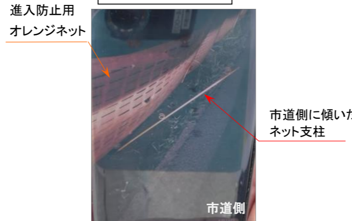
事故状況写真①
