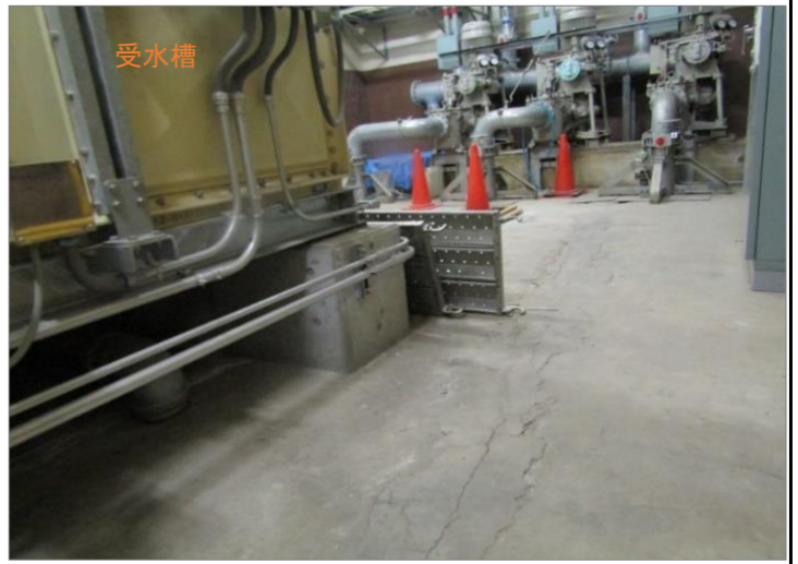
事故状況写真④ 200mm配管用コア抜き
