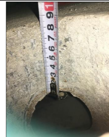
事故状況写真③ 配管埋設深さ85mm
