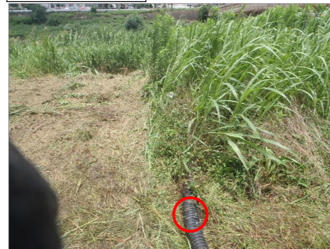
R1.7.12(撮影) 損傷箇所から低水路方向
