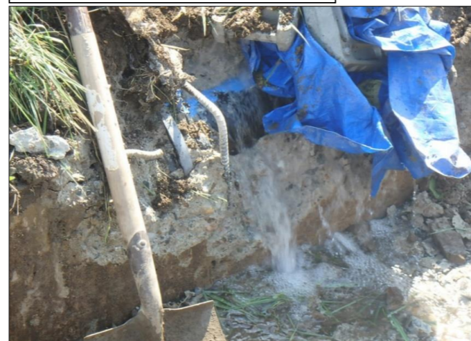
事故状況写真② 近景: φ150鉄管
