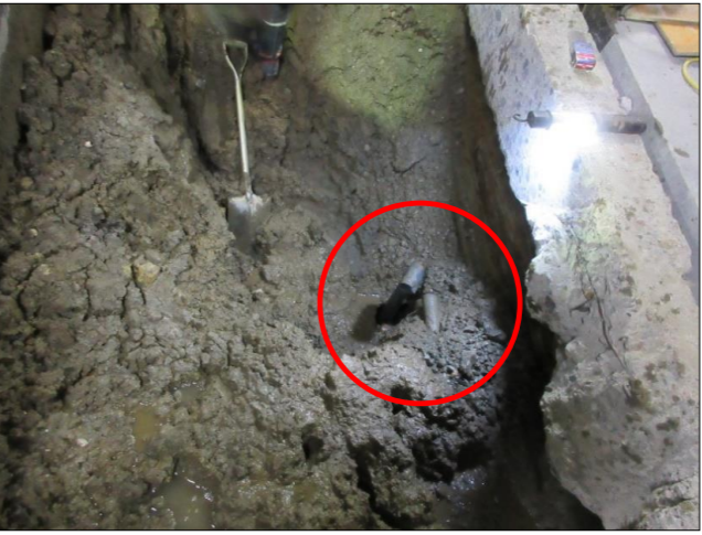
事故状況写真② 引き込み管の露出写真
