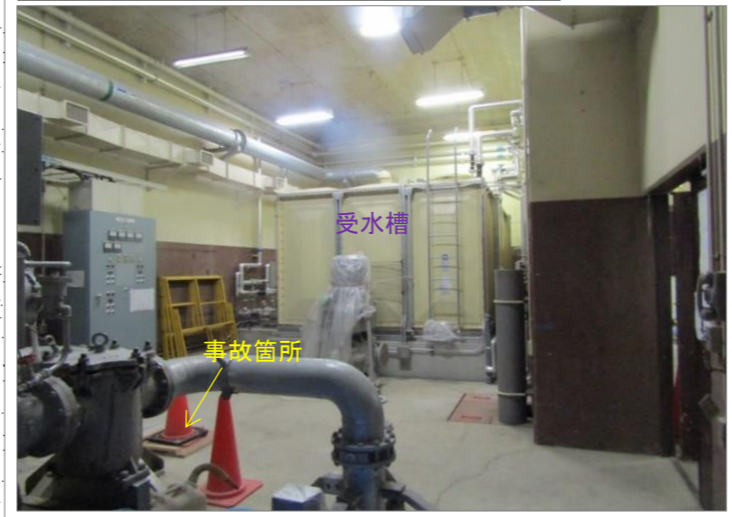
事故状況写真③ 配管埋設深さ85mm
