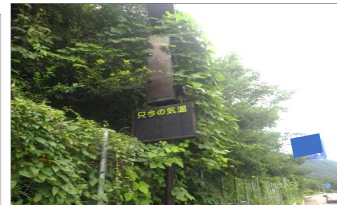
事故状況写真① 除草作業前
