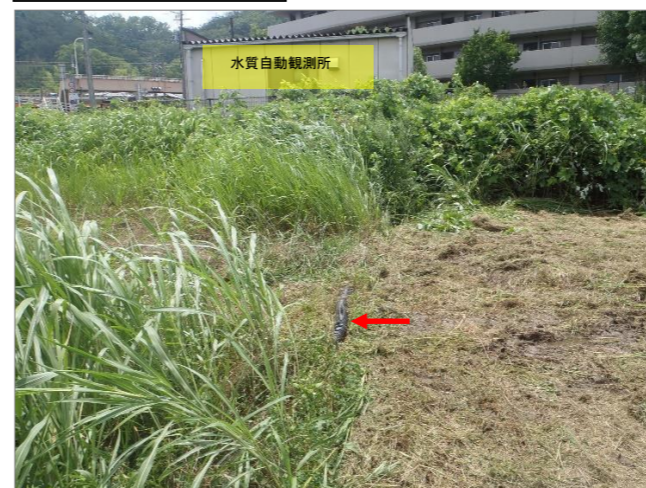
R1.7.12(撮影) 損傷箇所から観測所方向
