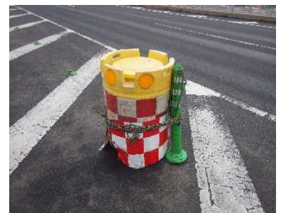
設置状況(中央部を固定)
