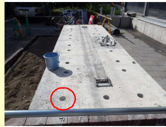
削孔径も標準より大きく不適切だった
