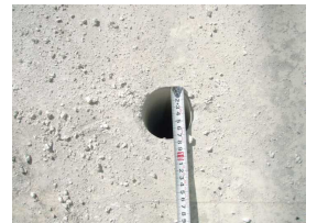
削孔径も標準より大きく不適切だった
