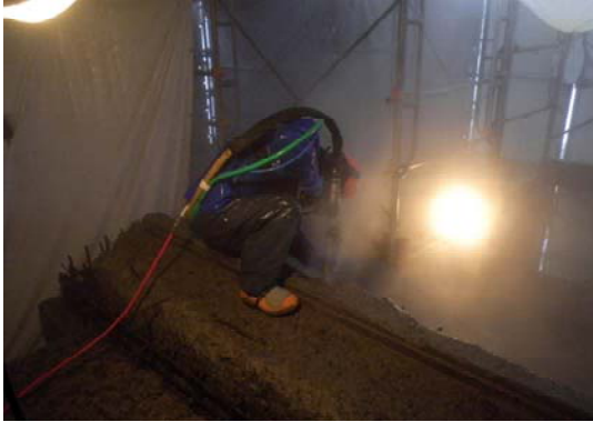
鉛直方向への作業状況(被災時は水平作業)
