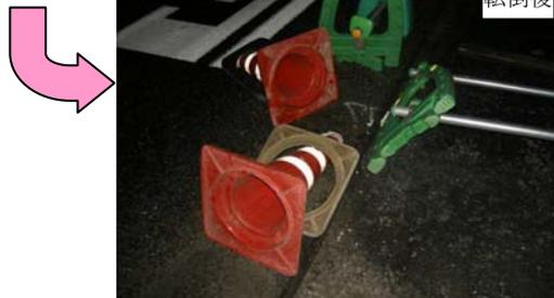
(事故概要) 10月15日深夜(強風注意報発令中)、中央分離帯に設置していた仮設単管バリケード(4m@2=8m)が突風で横倒し、通りがかった一般車の内1台が単管バリケードに接触損傷し、別の1台は急停止したが同乗者が車内で体をぶつけ、負傷した。(1台:バンパー損傷、1台:肘を怪我、程度不明)
