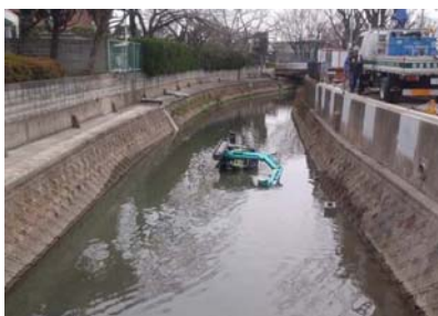
現場状況写真
