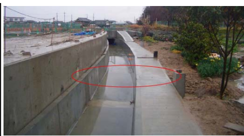
現場状況写真
