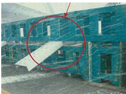
現場状況写真
