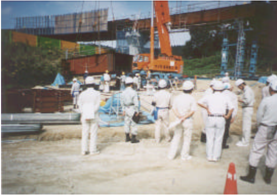
安全パトロールの様子
