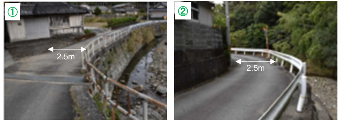
■ 工事中用道路の追加箇所(田子地区)
